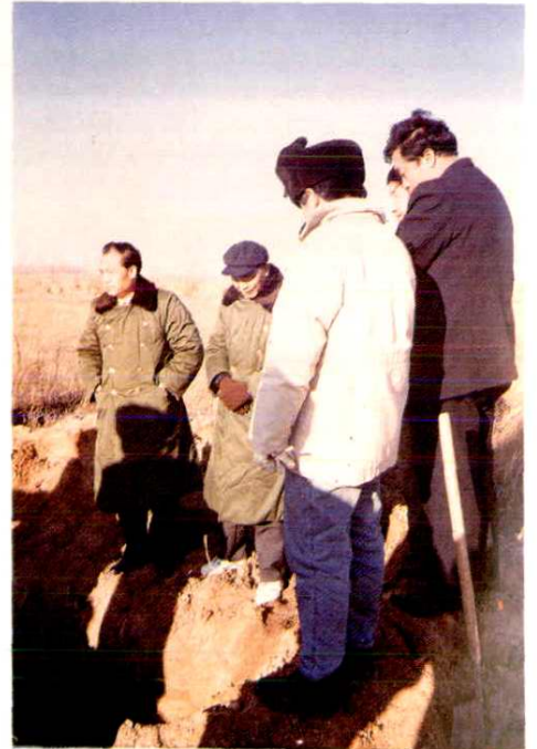
楊賢足副部長（左 1）在齊福生總經理（左 2）陪同下視察我局施工現場
