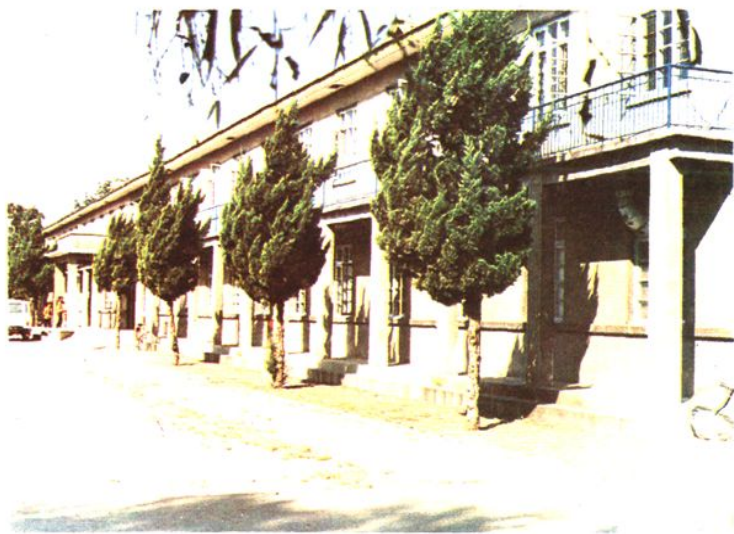
沂源县卫生防疫站办公楼
