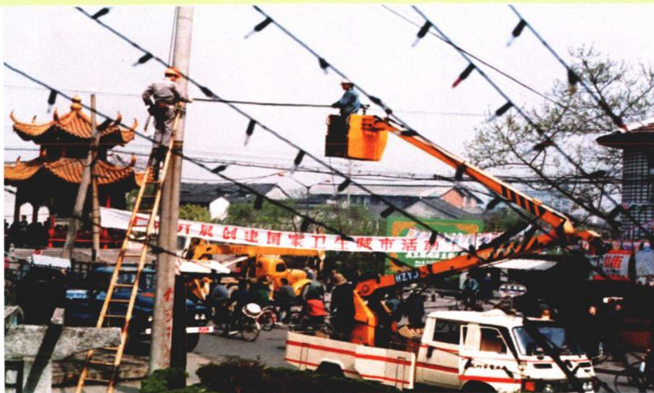
1992年4月14日， 杭州市电力局职工在 市区庆春路实施配网 改造
