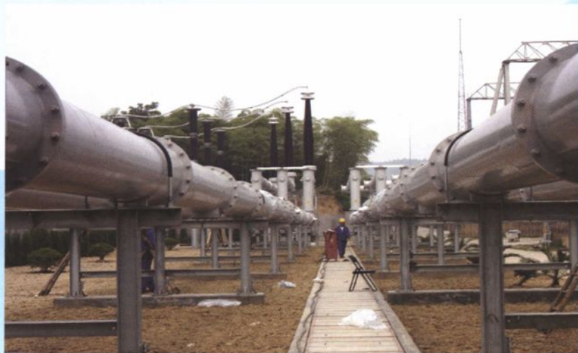
2004年3月14日~7月6日，500千伏瓶窑变电所系统改造中，瓶乔5411线与瓶武5905线换位及GIL管型母线安装作业
