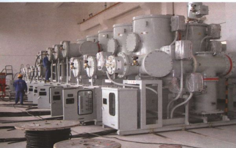
2005年11月18日，施工人员正在对杭州 市第一座实行公示制的220千伏庆丰变电所 110千伏GIS设备进行充气
