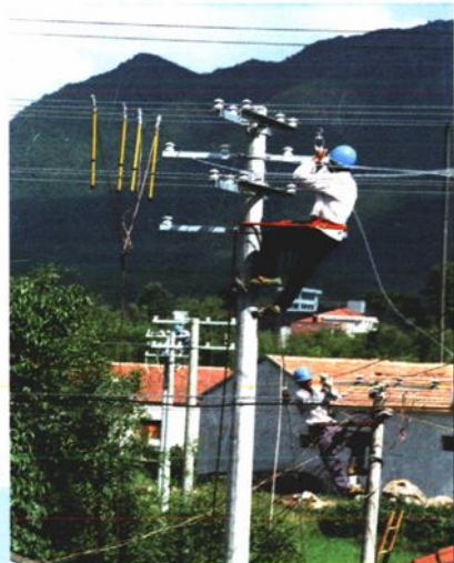
1993年农网改造 工程施工现场
