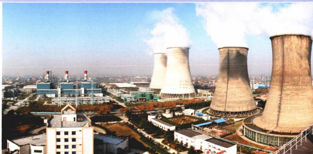
杭州华电半山发电有限公司
