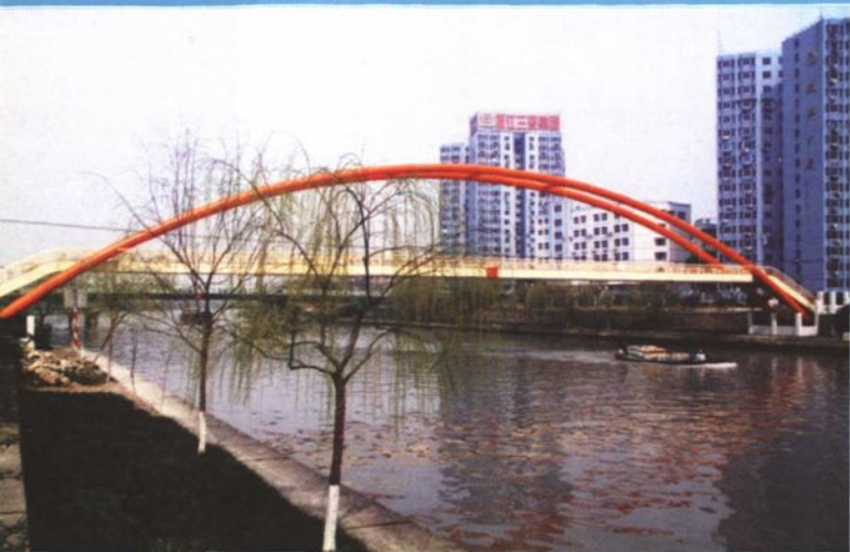
2000年，浙江省第一座跨越京杭大运河的110千伏电缆管桥建成
