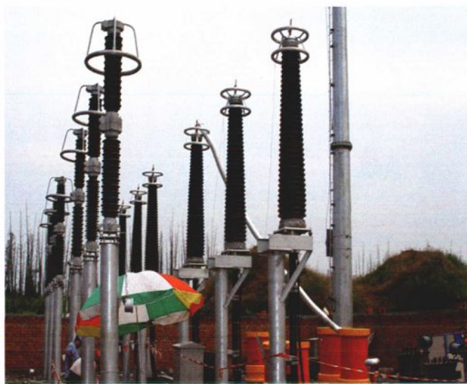
2004 年 9 月 27 日，钱江新城 220 千伏终端站乔景 4413 线、 乔芳 4414 线电力电缆试验现场
