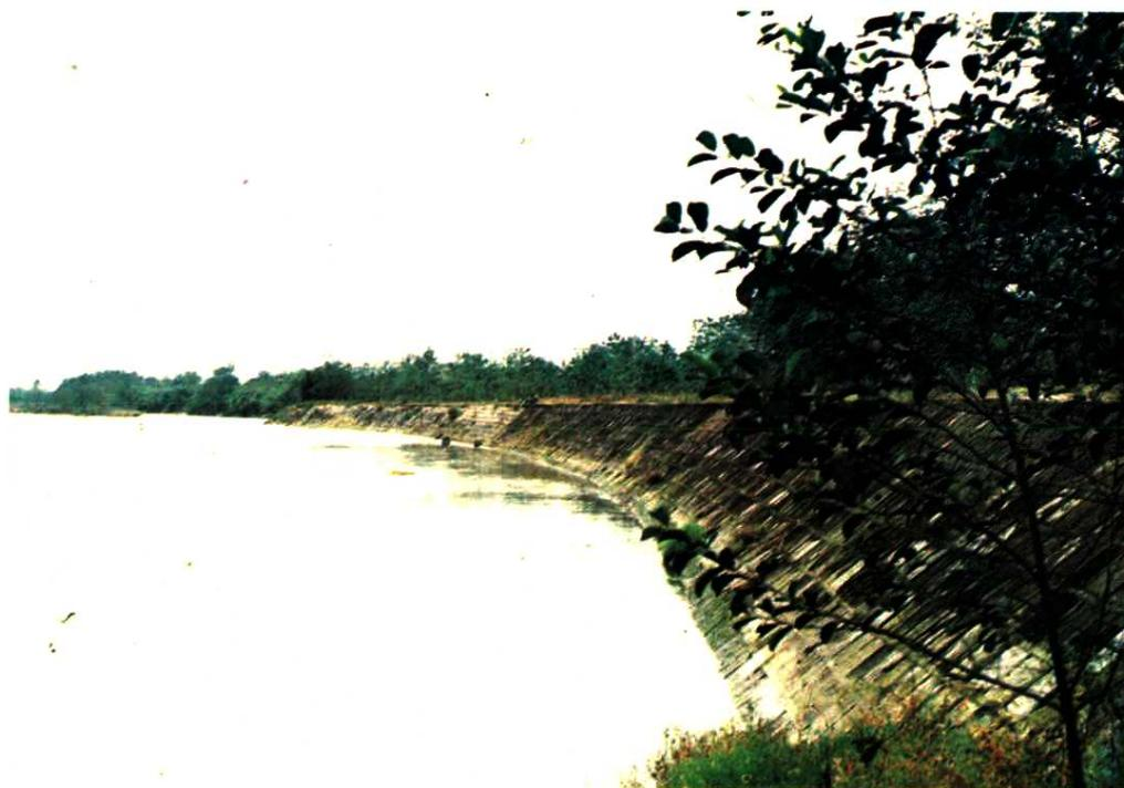
毗河二江沱混凝土预制块衬砌护岸工程
