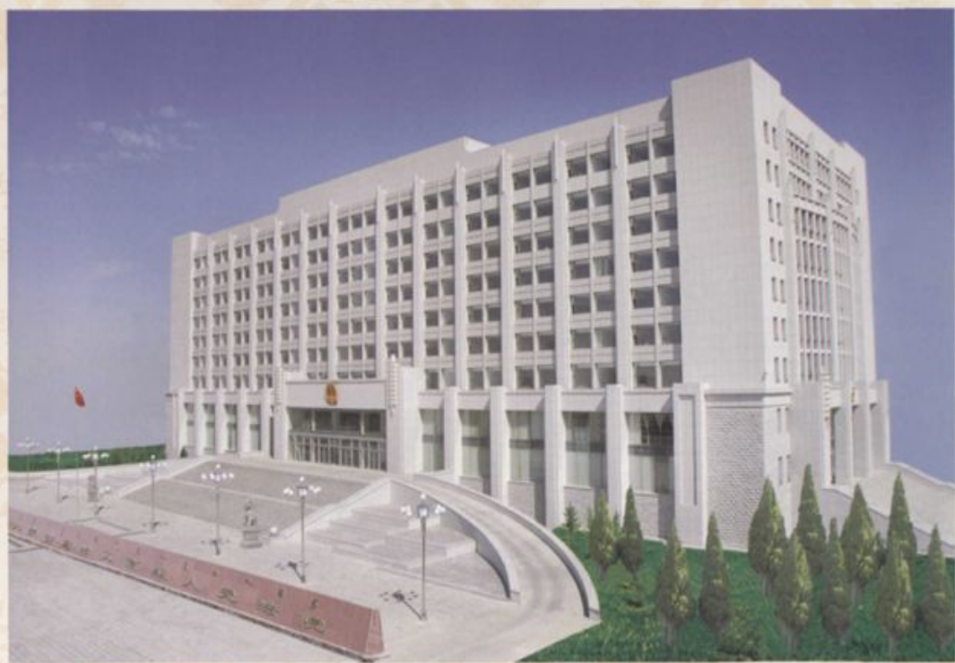
2005年设计并施工建成的内蒙古自治区高级人民法院新址
