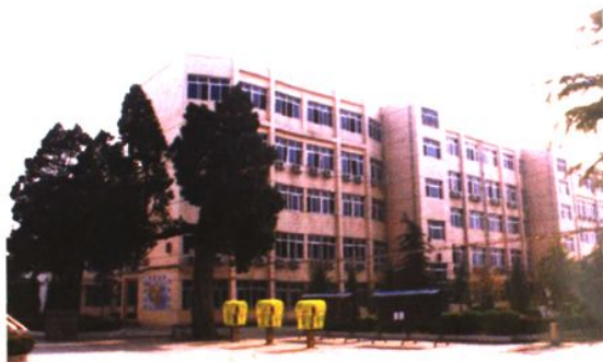
1995年建成的教学楼（北面）
