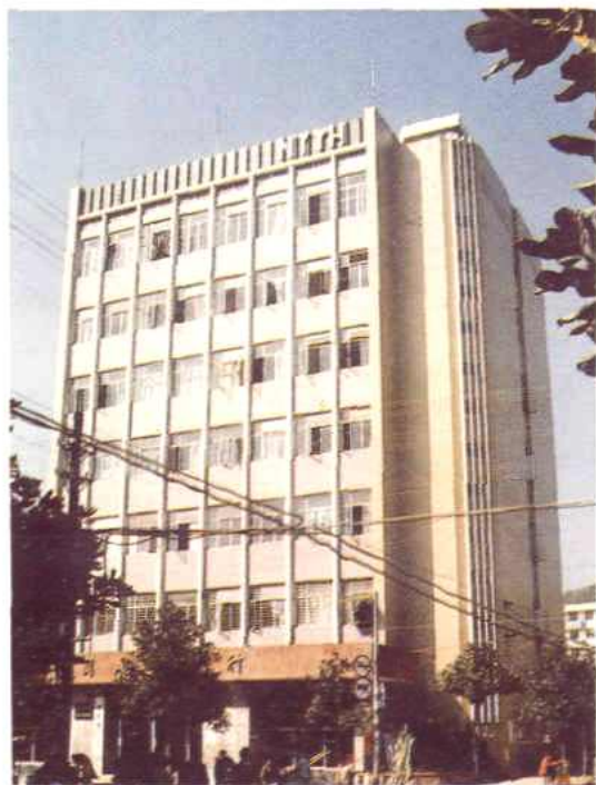
公司承建的中国农 业银行祁门县支行营业楼
