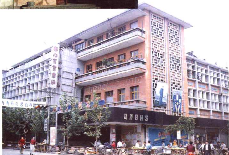
公司承建的 第一个大型钢筋 砼框架结构工程 —— 祁门百货商 场
