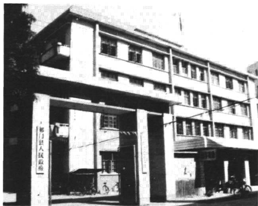
公司承建的县政府办公楼
