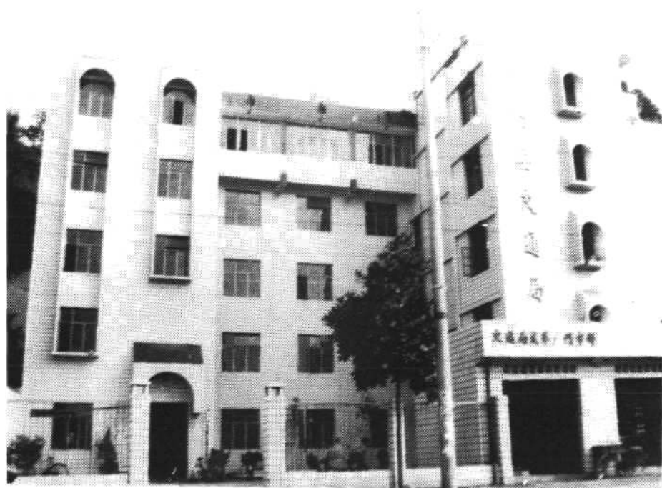
公司承建的县交通局办公楼
