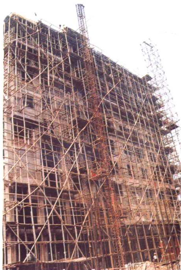
公司承建的 县内最高建筑工程—— 闽江大厦 正在施工
