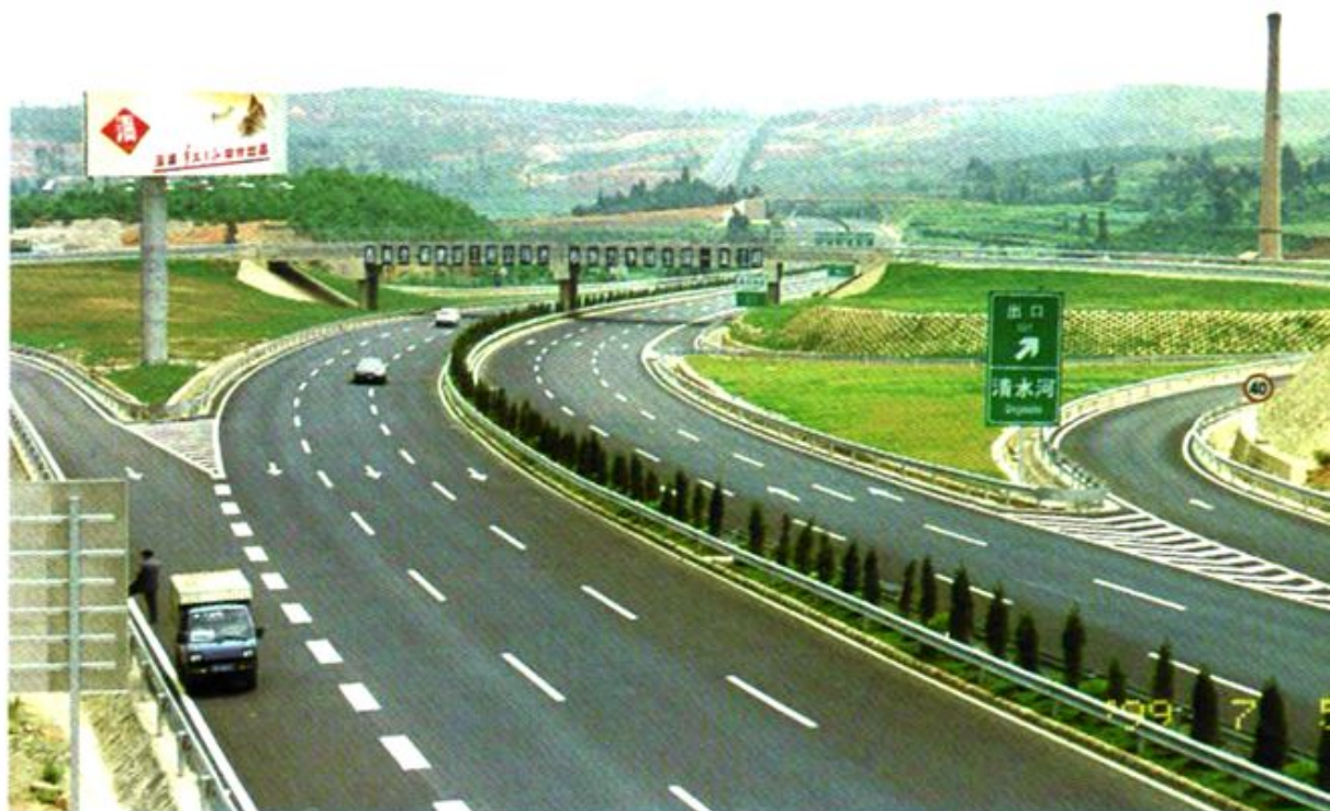
昆玉高速公路清水河立交区
