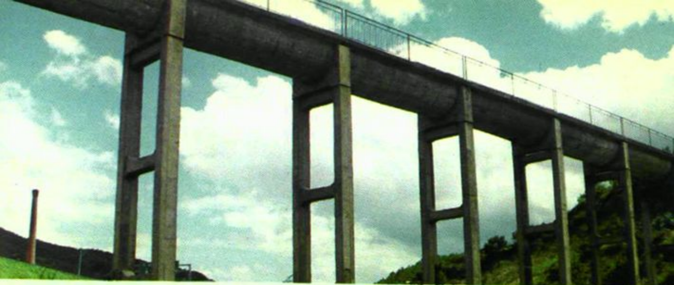
大春河干渠清水河 U 型高架渡槽
