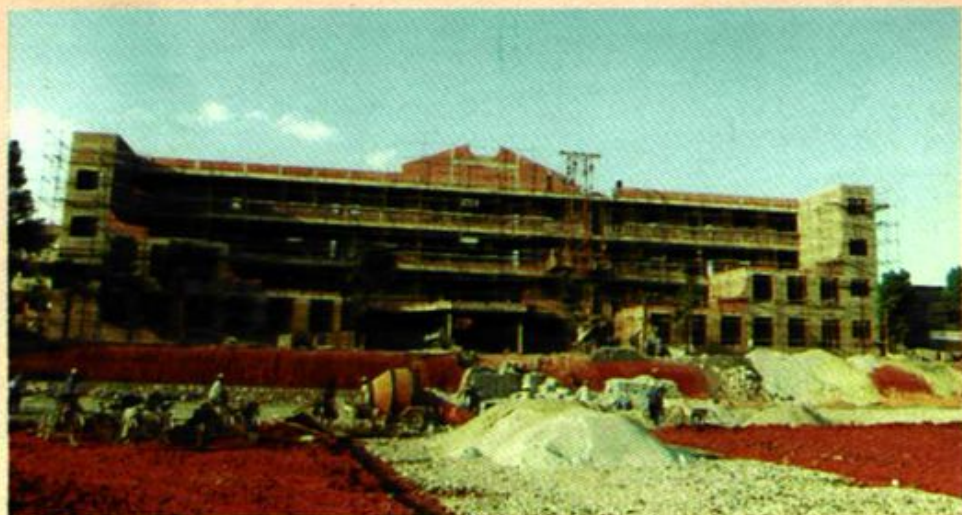
正在扩建中的宝峰中学综合大楼
