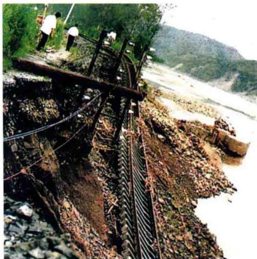
沈吉线铁路106千米处路基被洪水冲毁
