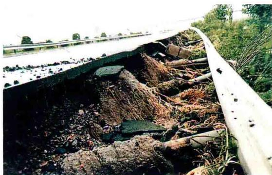
沈大高速公路28~29千米处被洪水淹没冲坏
