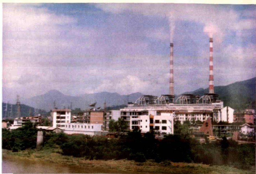
总装机容量6万千瓦的漳平电厂
