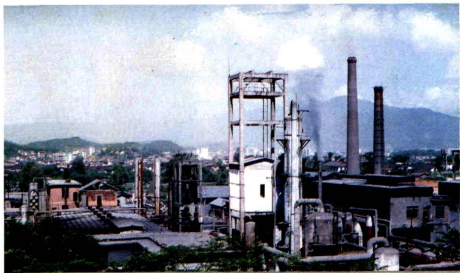
漳 平 化 肥 厂 全 貌
