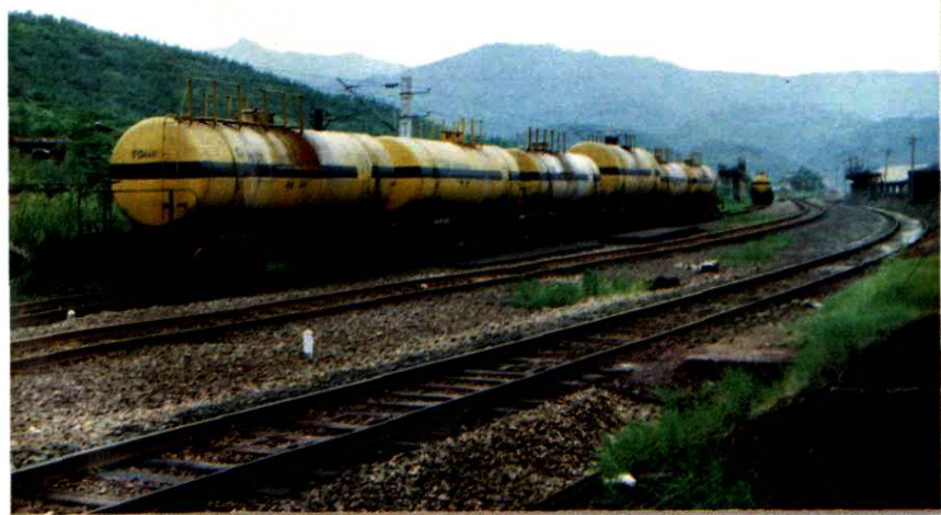
漳平硫酸 厂铁路专用线 和自备硫酸罐 车
