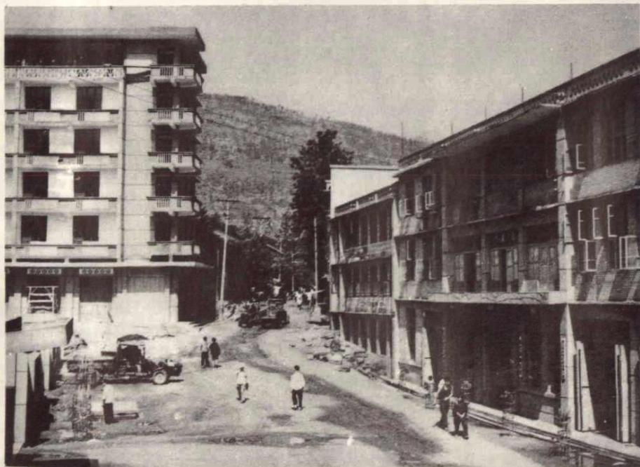
建设中的 县城主要 街道——金 江街。
