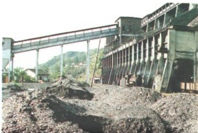
广东省四望嶂矿务局二、三矿煤台
