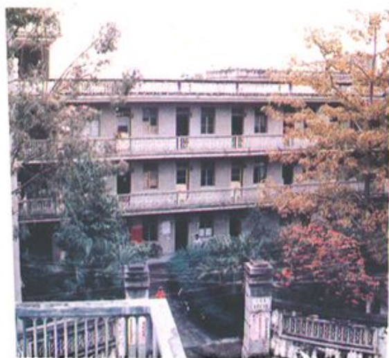
坐落在梅州市区的梅县矿务局局本部办公楼
