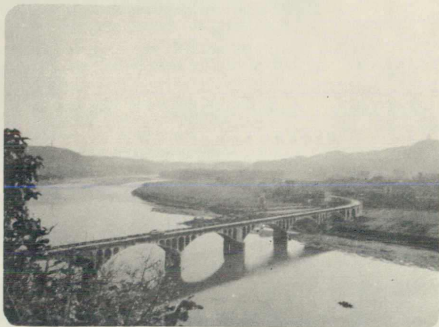
位于巴城东部的巴中大桥，全长464米。1970年建成。
