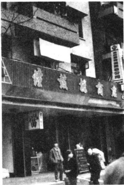
图二 县联社废旧回收公司钟鼓楼商店
