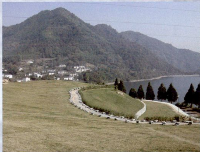
正在建设中的区923重点工程 ——中国黄山龙裔公墓扩建工程
