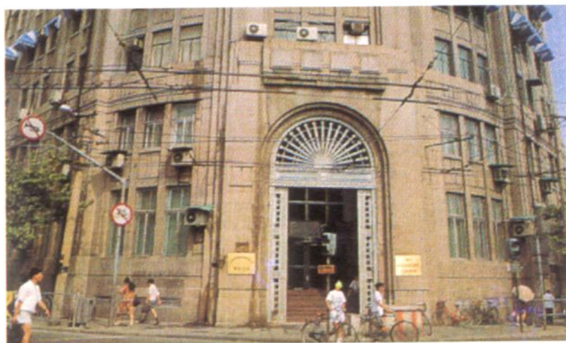
钢铁公司（北京东路342号）
