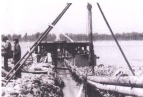
□ 黄台发电厂灰管穿越黄河河底设计，采用水冲振动沉管法施工，1985 年获国家级科技进步三等奖
