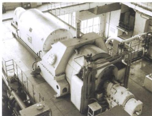
□ 1959年，设计的山东青岛发电厂2.5万千瓦发电机组
