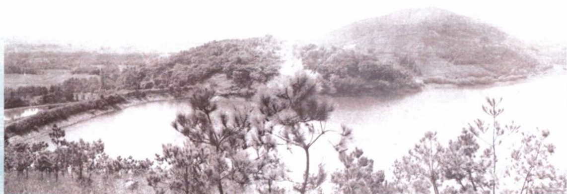
1952年首批兴建的龙虎坝水库
