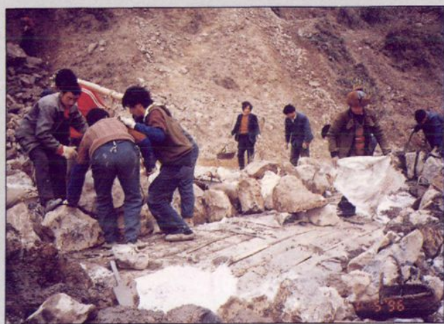
道武公路卡门段施工现场
