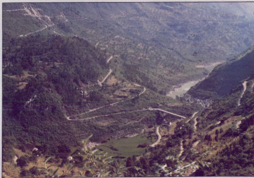
芭蕉湾至桃源公路的震心岩至老虎岩段 十六公里二十一个弯道
