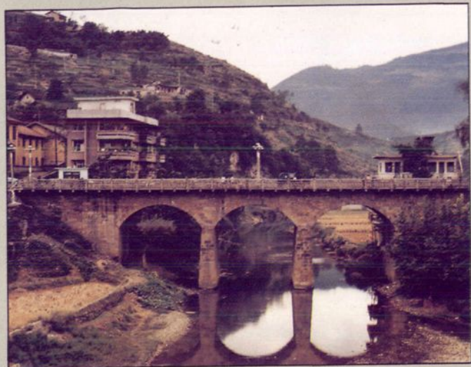
解放后修建的第一座公路桥——玉溪桥
