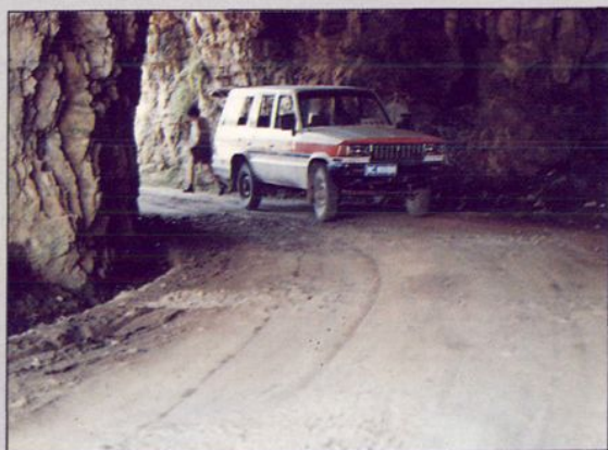
道武公路观音岩天然隧道
