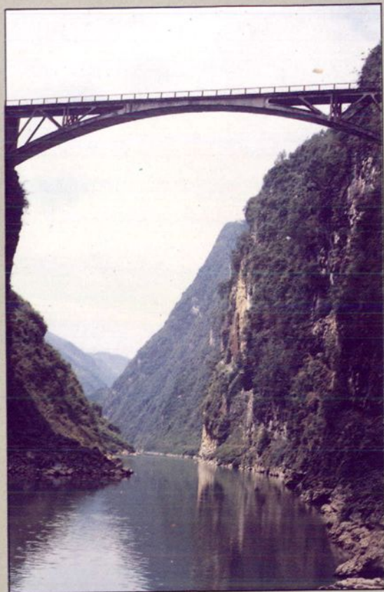
贵州首创的桁式组合拱科研桥—— 长岩大桥
