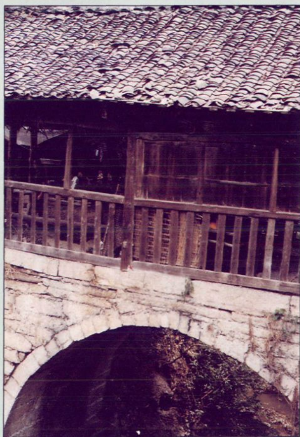
清同治年间修建的风雨桥——石桥桥
