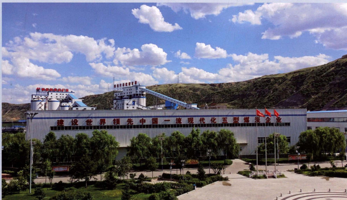
公司工业厂区
