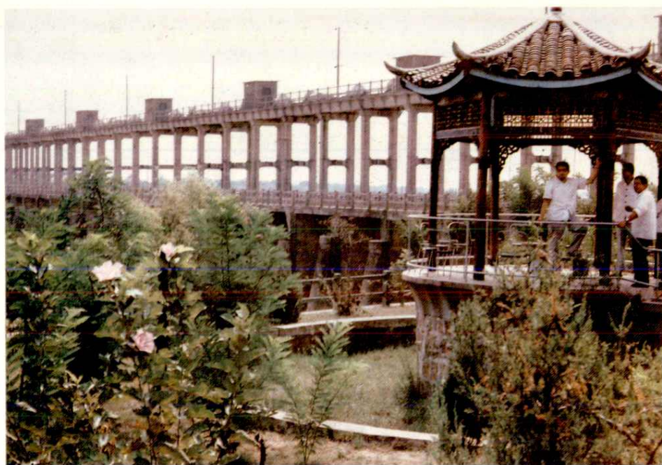
曹台孜退水闸
