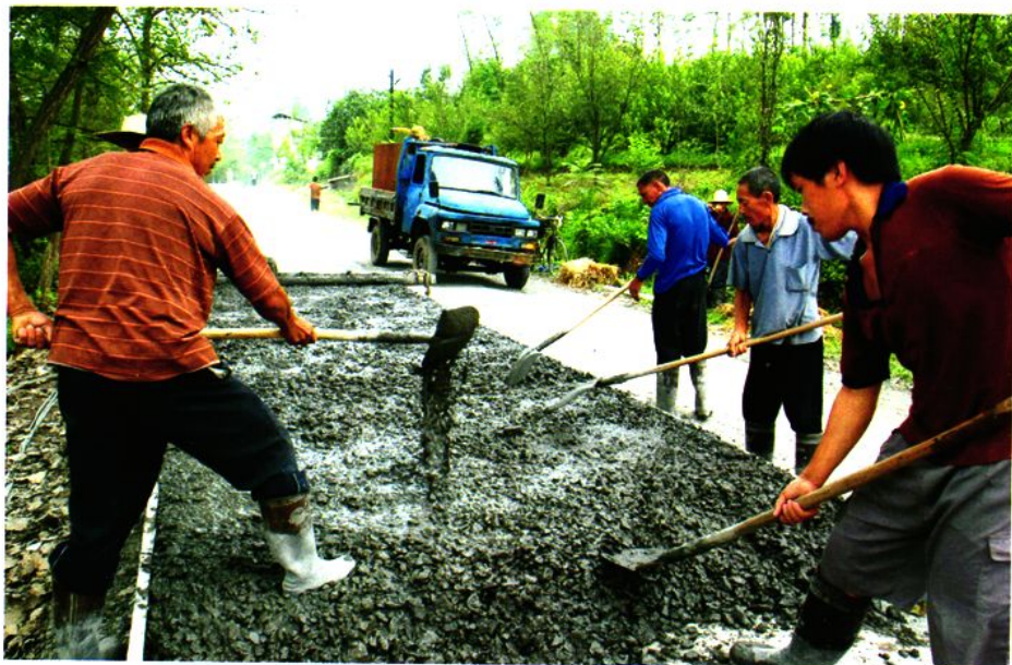
公路建設現場
