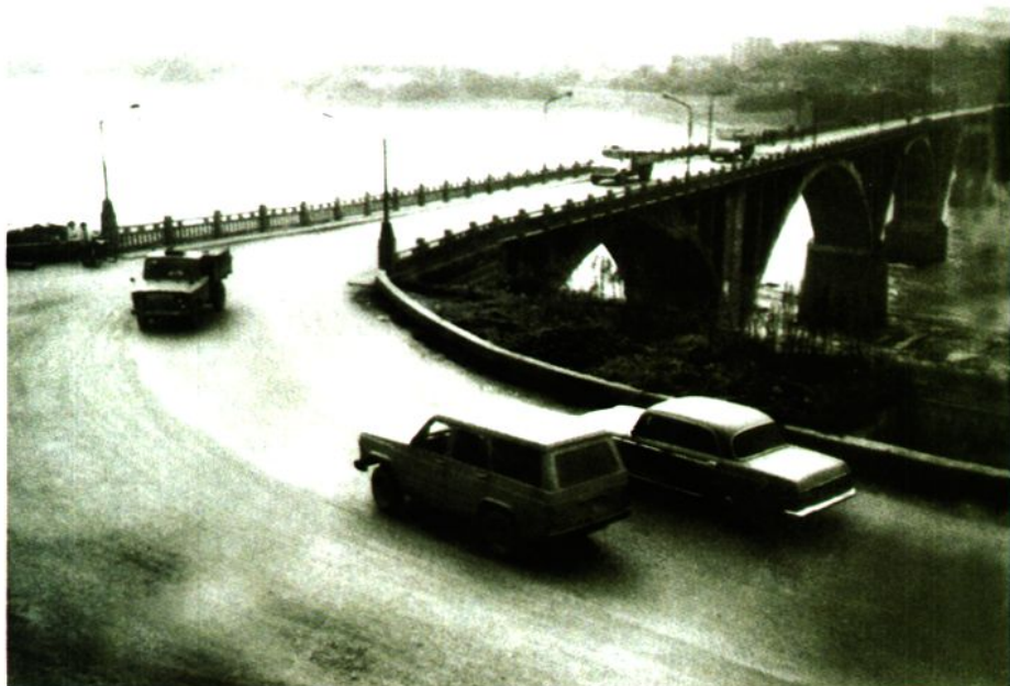
广安渠江大桥(1978年建成通车)
