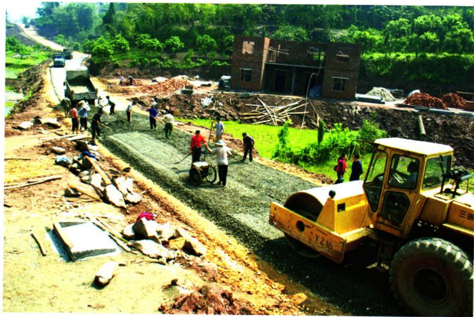
公路建設現場
