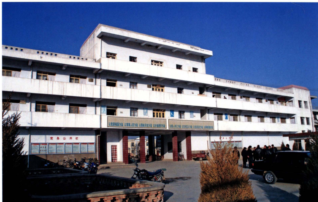
西川镇政府办公楼
