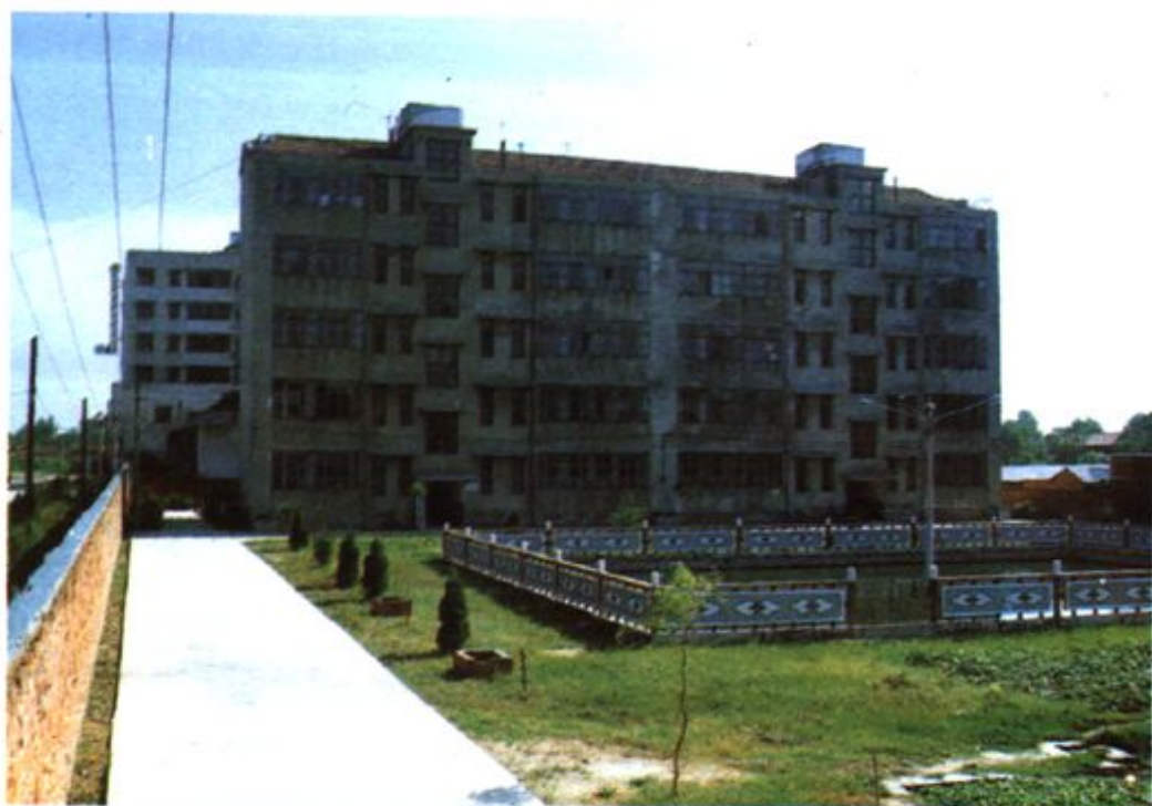
县社会劳动保险公司办公楼
