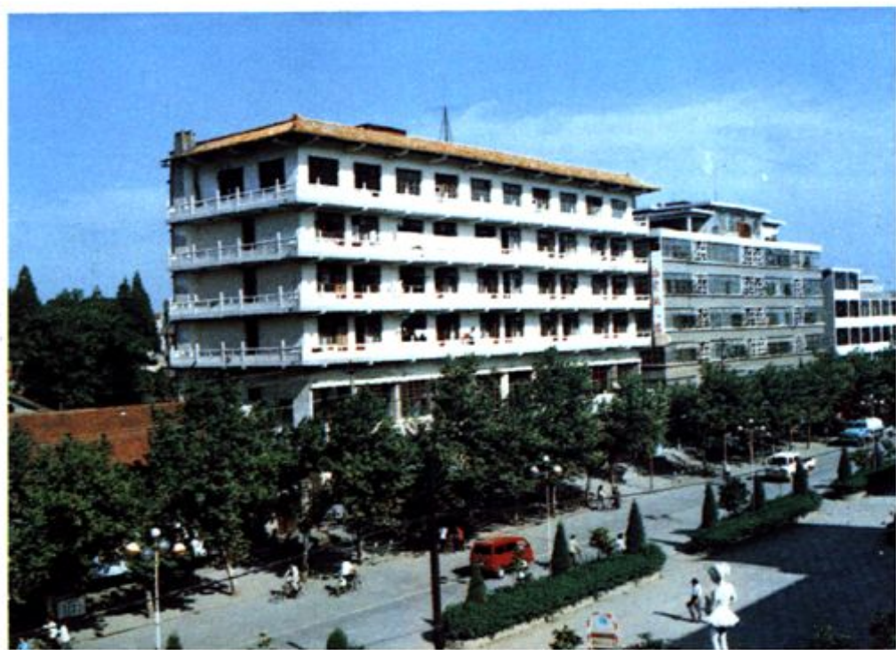
第四技校实验大楼
