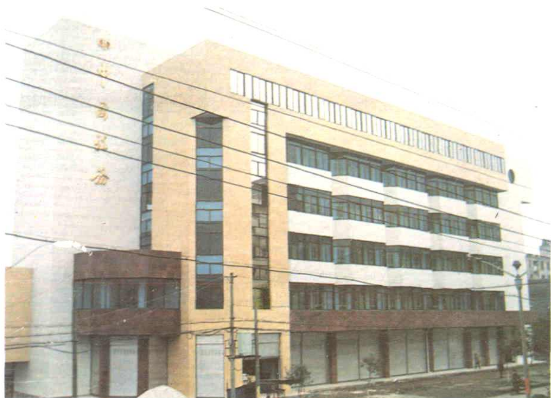
雅安地区税务局办公大楼
