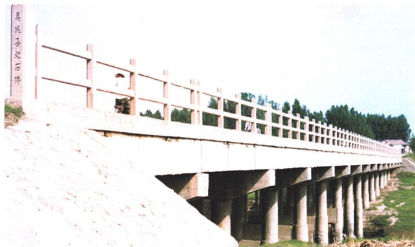
■ 徒骇河北石桥公路桥
