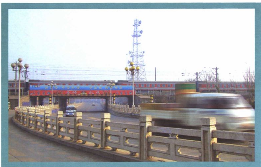
解放路铁路立交桥
