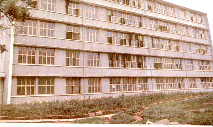
地区教育学院教学大楼
