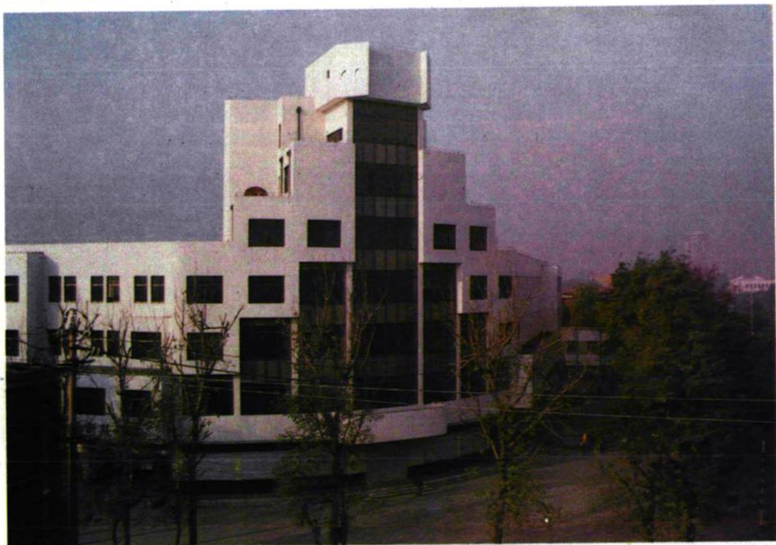
潍坊市科学技术委员会办公楼
