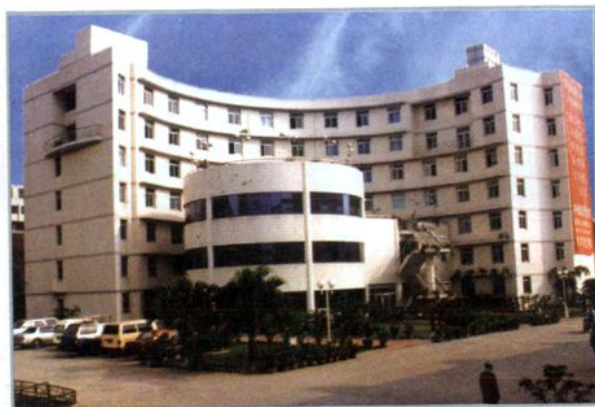
△ 崇州市第九建筑安装工程公司承建工程： 成都市市委办公大楼
