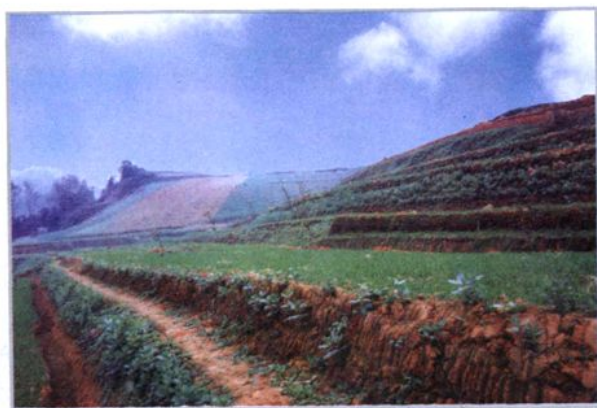
△ 国家生态环境建设项目——道明“坡改梯”工程
