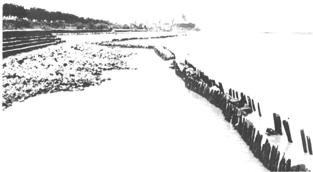
▲常熟野猫口險工段桩石、抛石和砌石护岸工程
