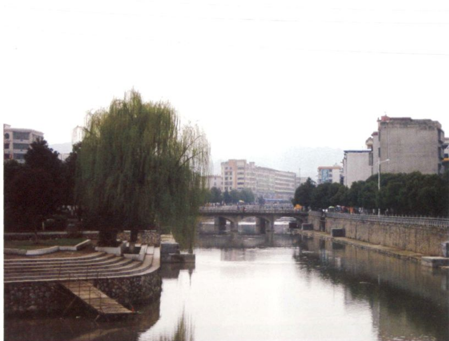
办理武水河治理议案后，面貌一新的文昌桥河段（1997）
