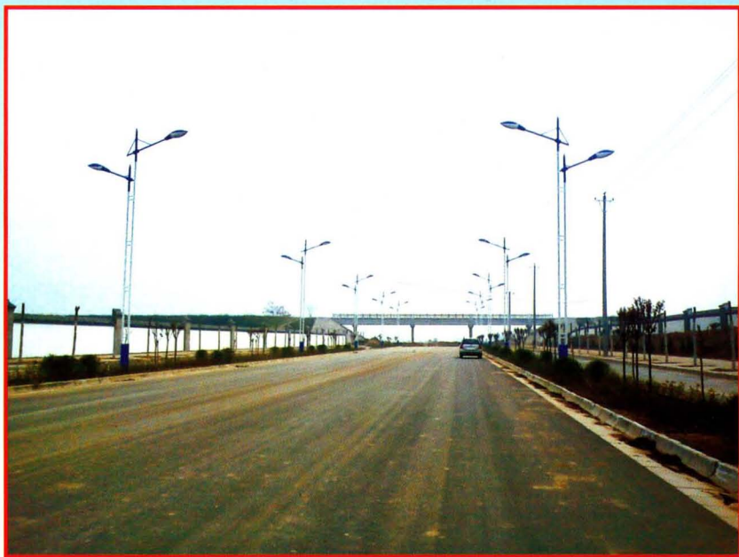
新建的园区七横路
