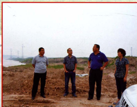
市局建设处处长田慧枫 (左二)检查我县二级 网化工程
