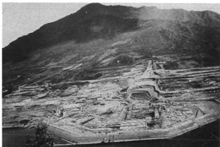
右岸围堰施工
