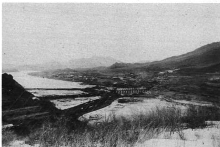
左岸围堰施工
