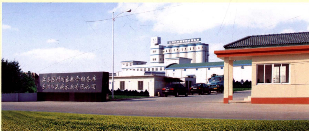
江苏苏州国家粮食储备库（郭巷九盛港路158号，2004年建成）
