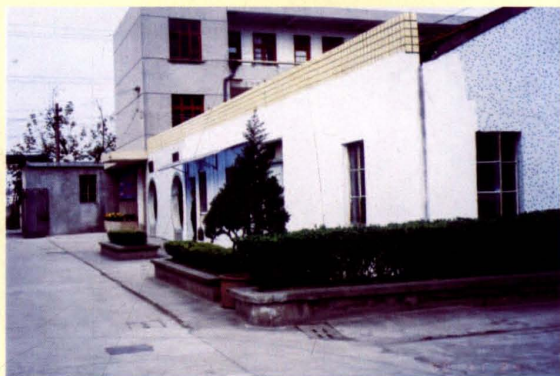
苏州粮油食品有限公司 (南门路48号, 2003年拆迁至黄桥张庄工业区)
