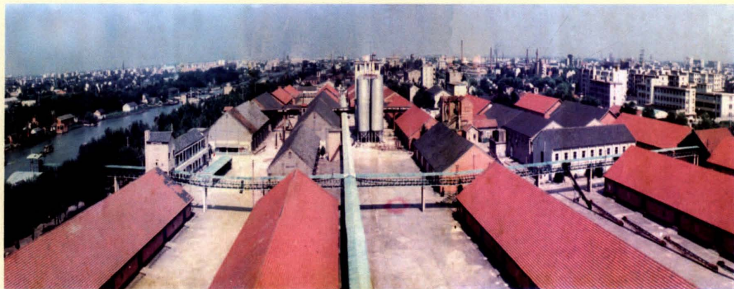
江苏苏州国家粮食储备库（南门路51号，2002年拆迁至郭巷九盛港路158号）
