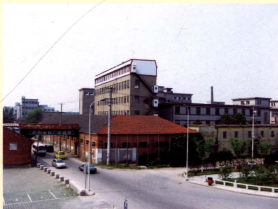
苏州太和面粉有限公司 （南门路42号，2003年拆迁至盐城阜宁）
