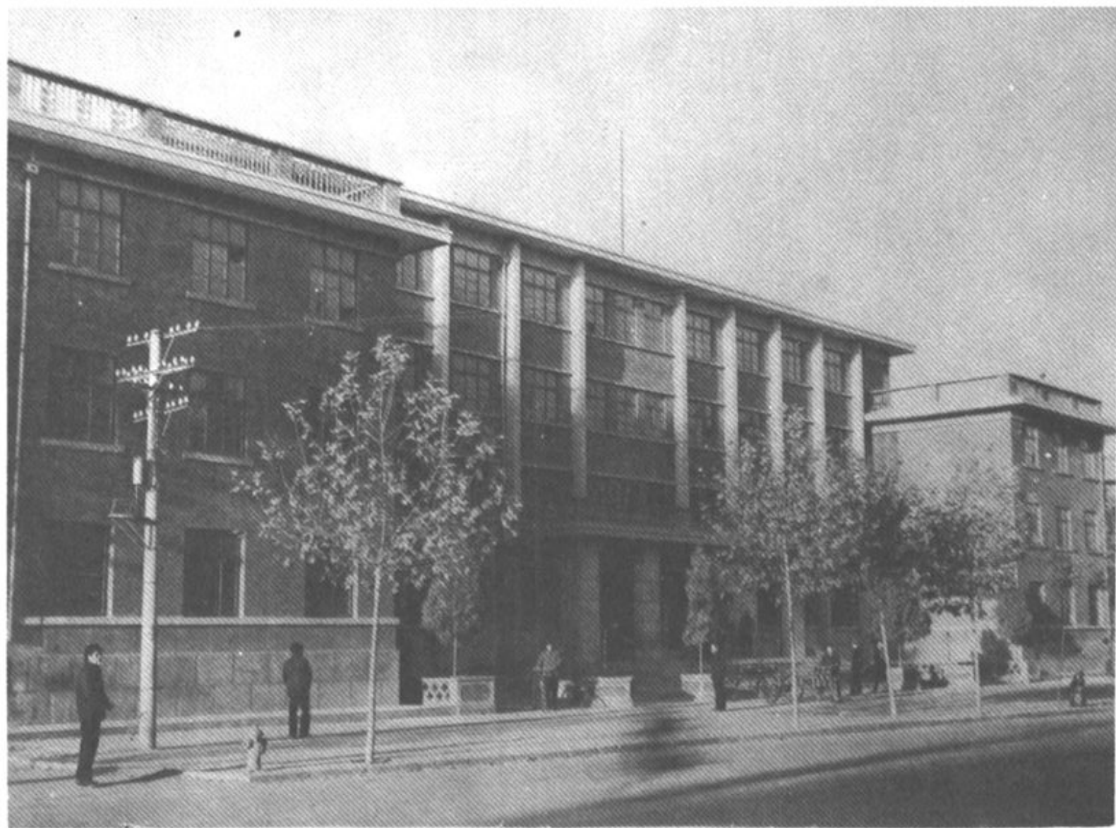
县社办公大楼
