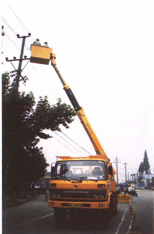
2000 年 6 月，湖州电力局首次在 10 千伏配电线路开展带电作业
