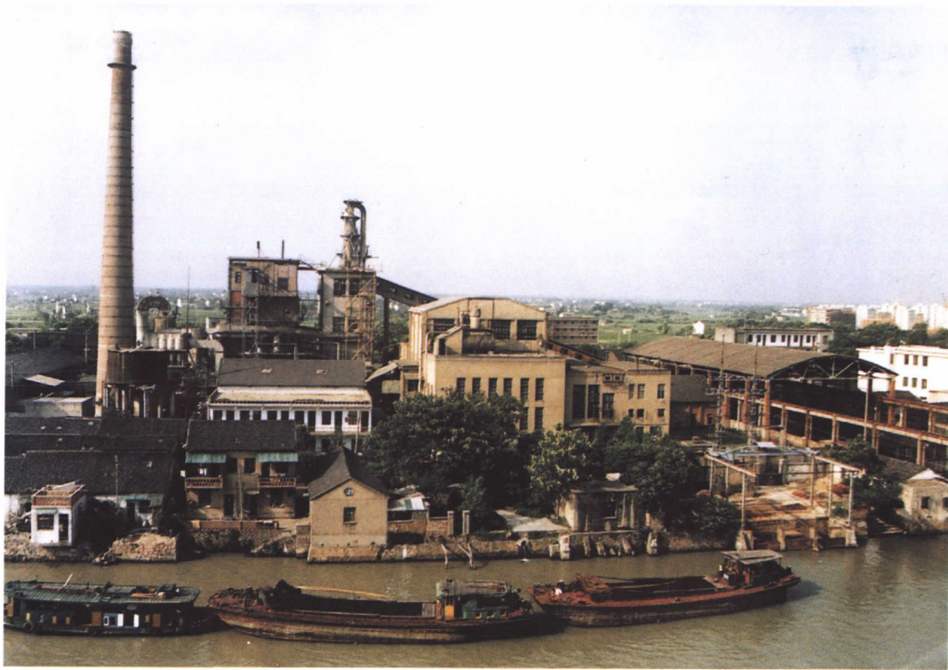
湖州苕溪之畔的湖州发电厂
