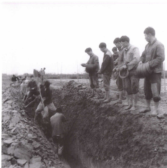
1973年起，吴兴县电力公司在农村推广地埋线代替架空电力线路
