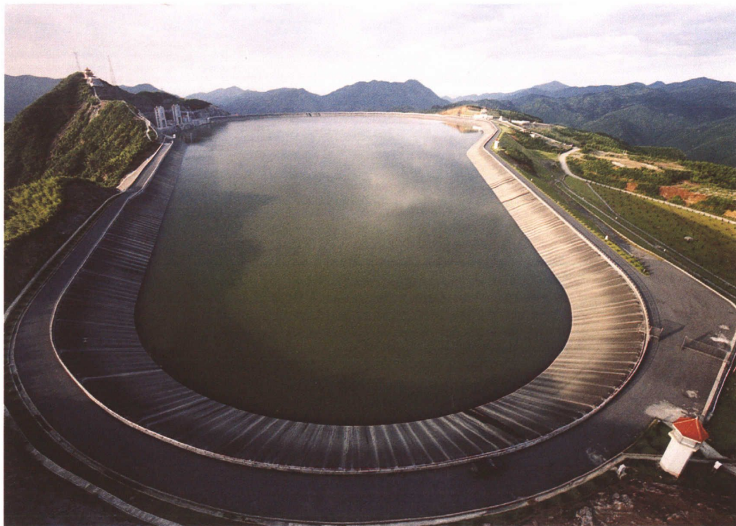
天荒坪抽水蓄能电站上水库全景
