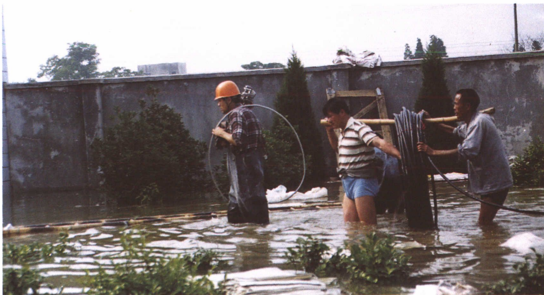
1999 年特大洪灾中湖州电力职工奋力抢修电力设施
