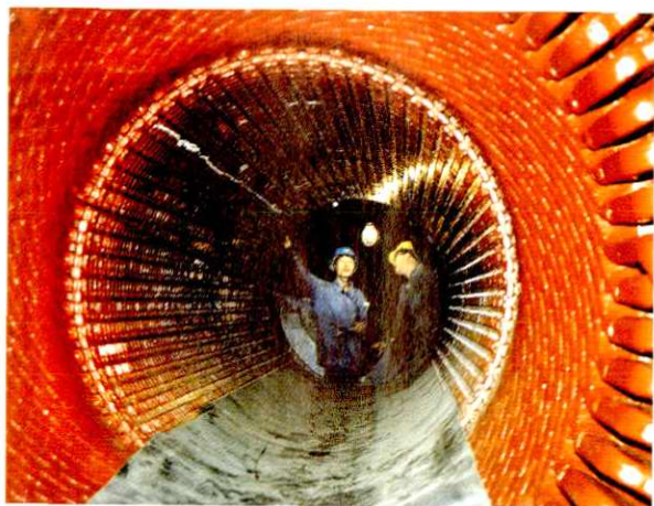
发电机定子检修
