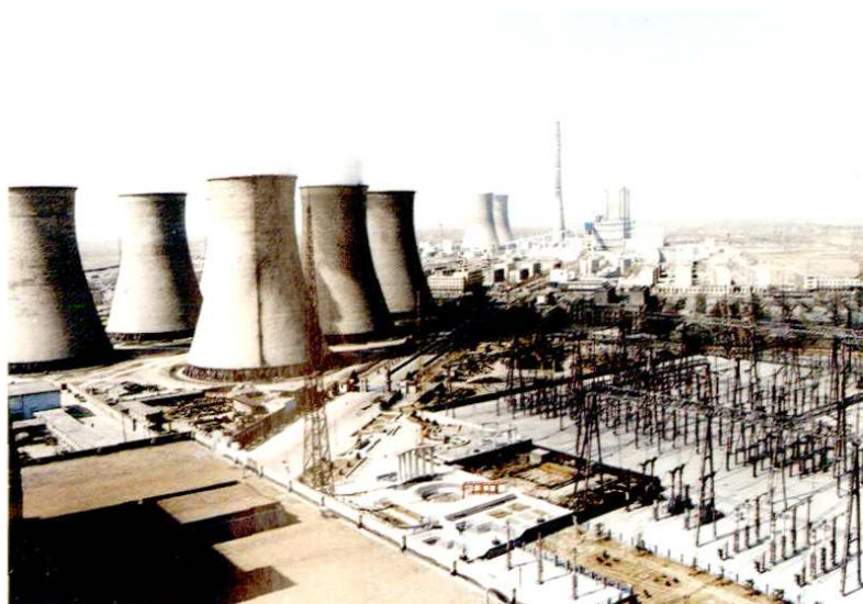
冷却塔与升压站鸟瞰
