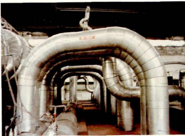
二单元锅炉楼顶房
