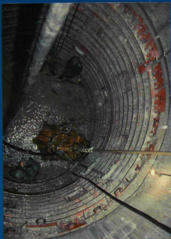
整体模板支护竖井井筒
