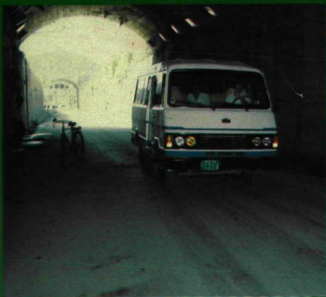
黄石315 隧道工程
