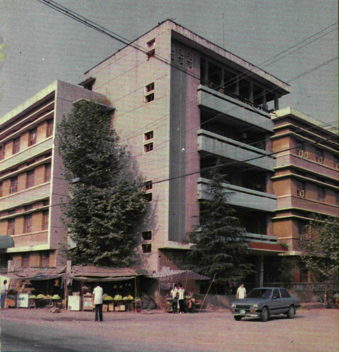
井巷公司办公大楼
