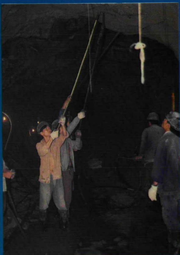
注锚杆支护巷道
