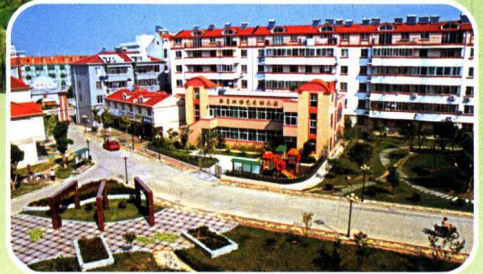
庐城越城花园小区园景
