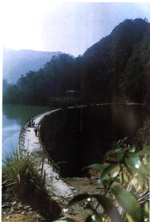
1995年，即将建成的双河口电站大坝。
