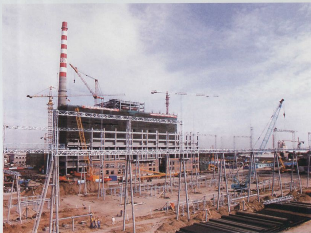
建设中的通辽热电厂六期工程
