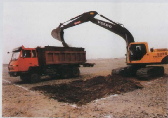
通辽发电厂三期工程开工
