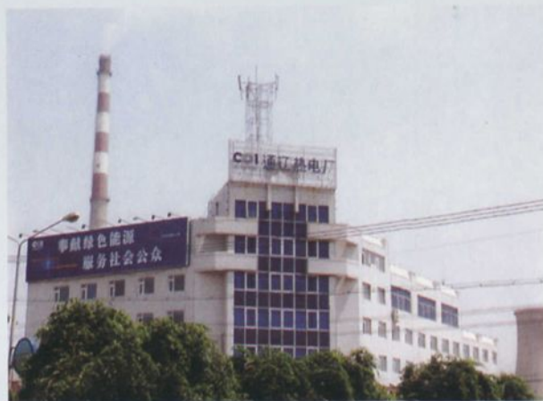
通辽热电厂办公楼
