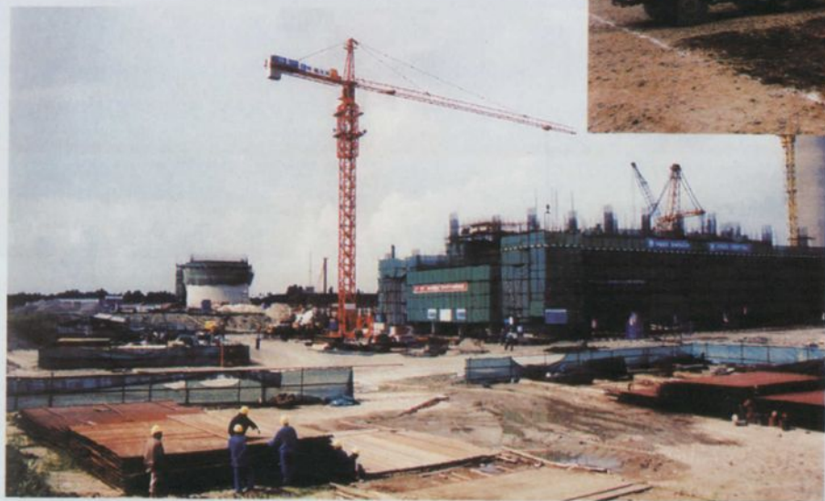
通辽发电厂三期工程建设工地
