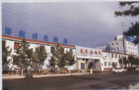
通辽热电厂大门
