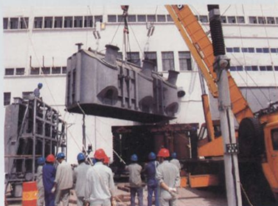
主变压器大修
