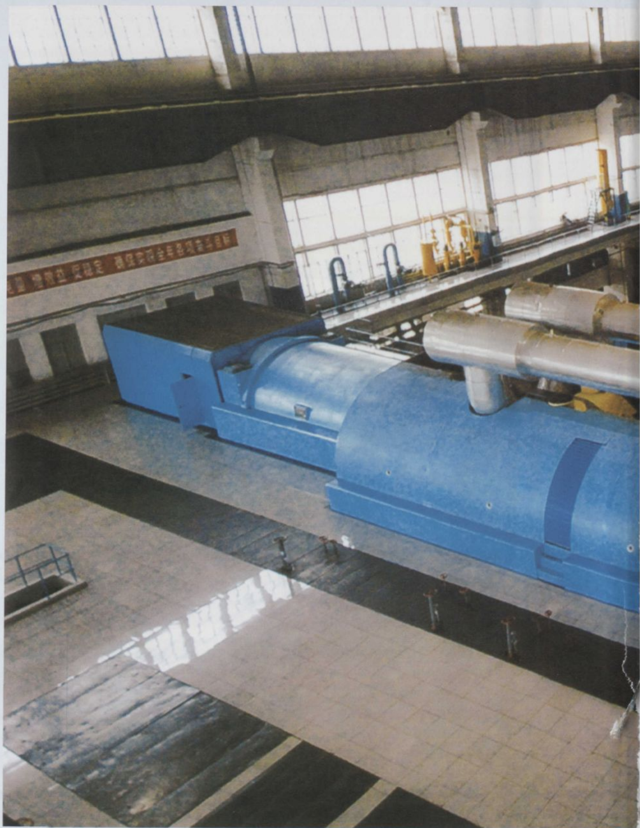
通辽发电总厂本部汽机厂房
