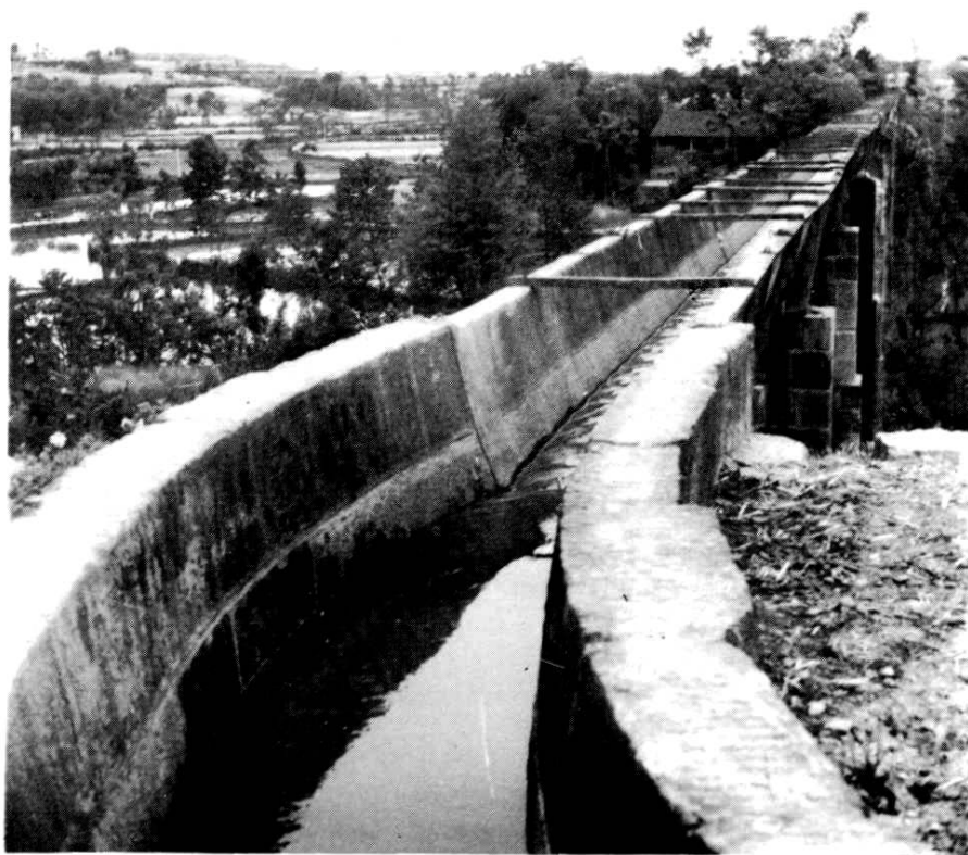
桂花湾水库薄壳渡槽
