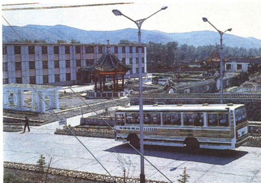
化工六厂厂区一角
