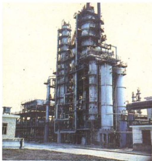
新建年处理20万吨原油的炼油装置
