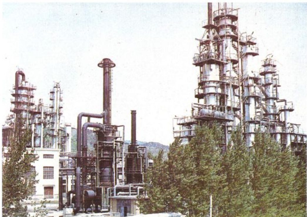
①炼油厂年吞20万吨原油的炼油塔
