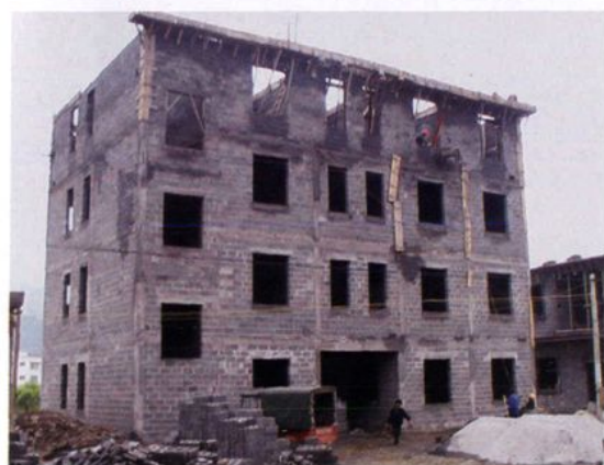
在建的石耶镇派出所
