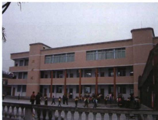
石耶中心校综合楼
