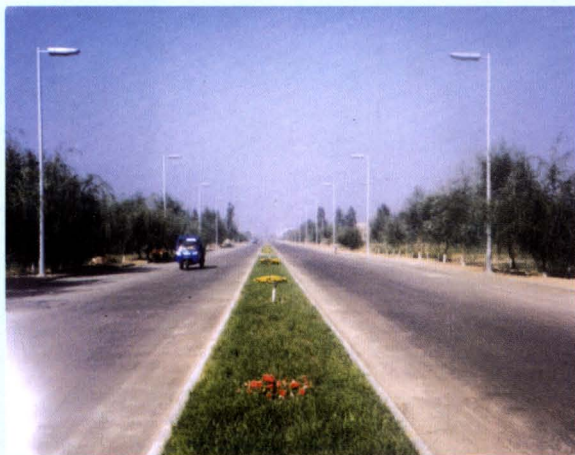
◀ 2003年由交通局施工建设的南三环东路
