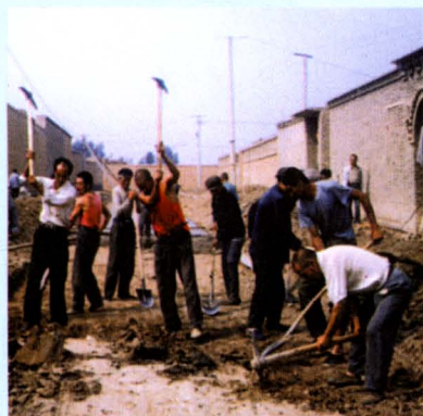
▲ 南泉乡村通水泥路施工现场
