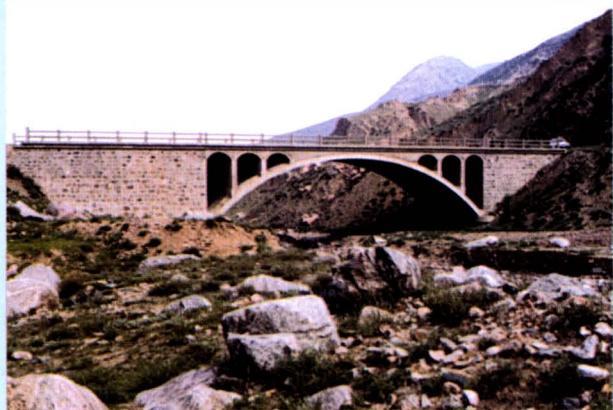
◀ 北楼口双 曲拱桥
