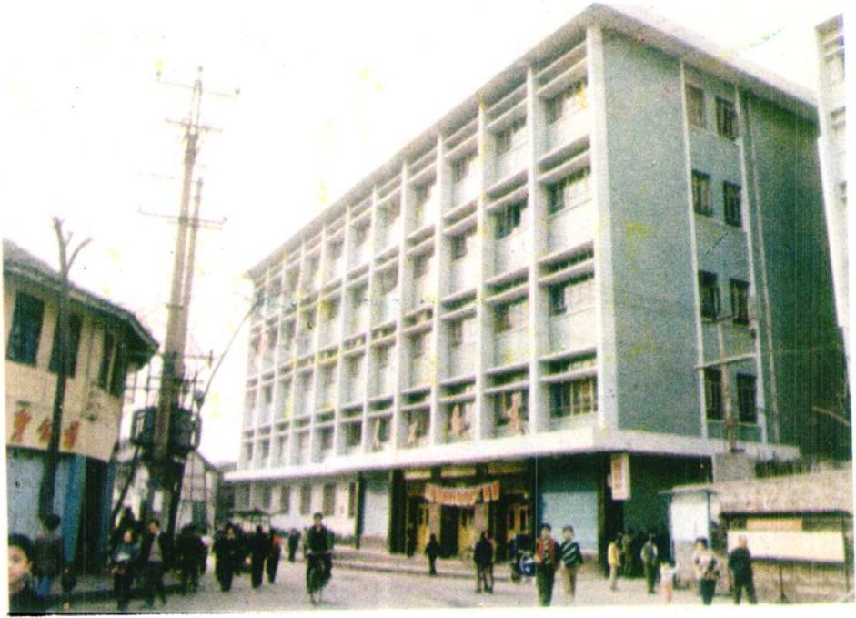
合川县邮电综合生产大楼
