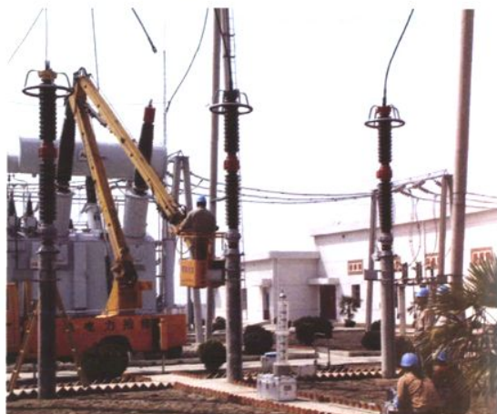
2004年，职工在变电所检修断路器
