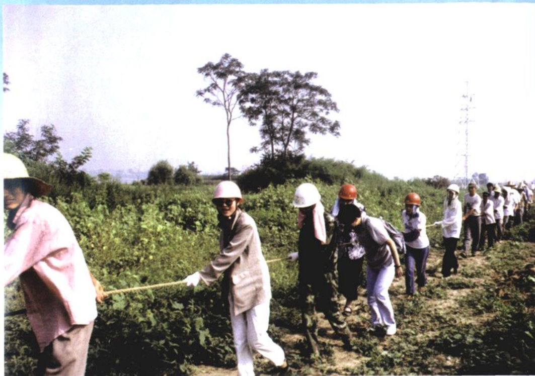
1999年，滁州电业局机关管理人员参加定远110千伏线路施工
