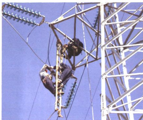
2003年，线路职工在维修线路
