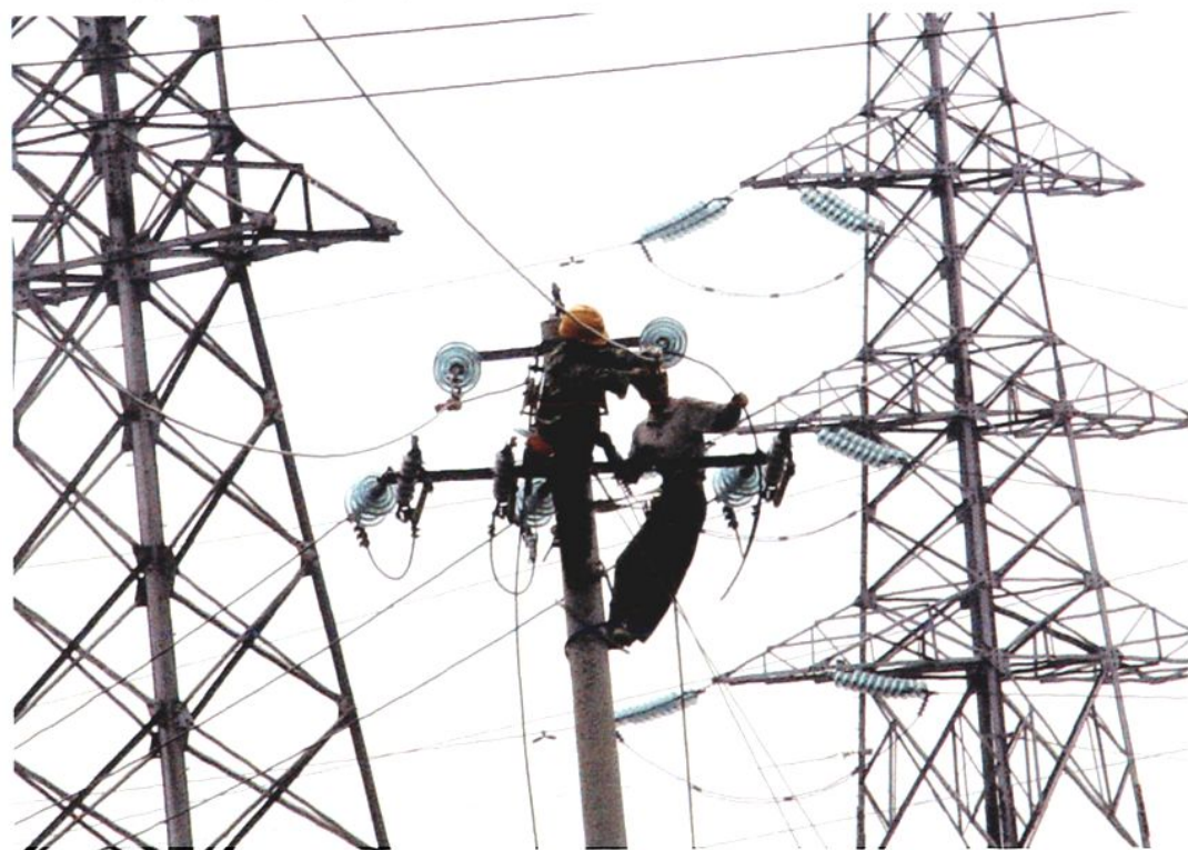
1999年，输变电安装公司职工在110千伏定远至曲阳双回线路施工
