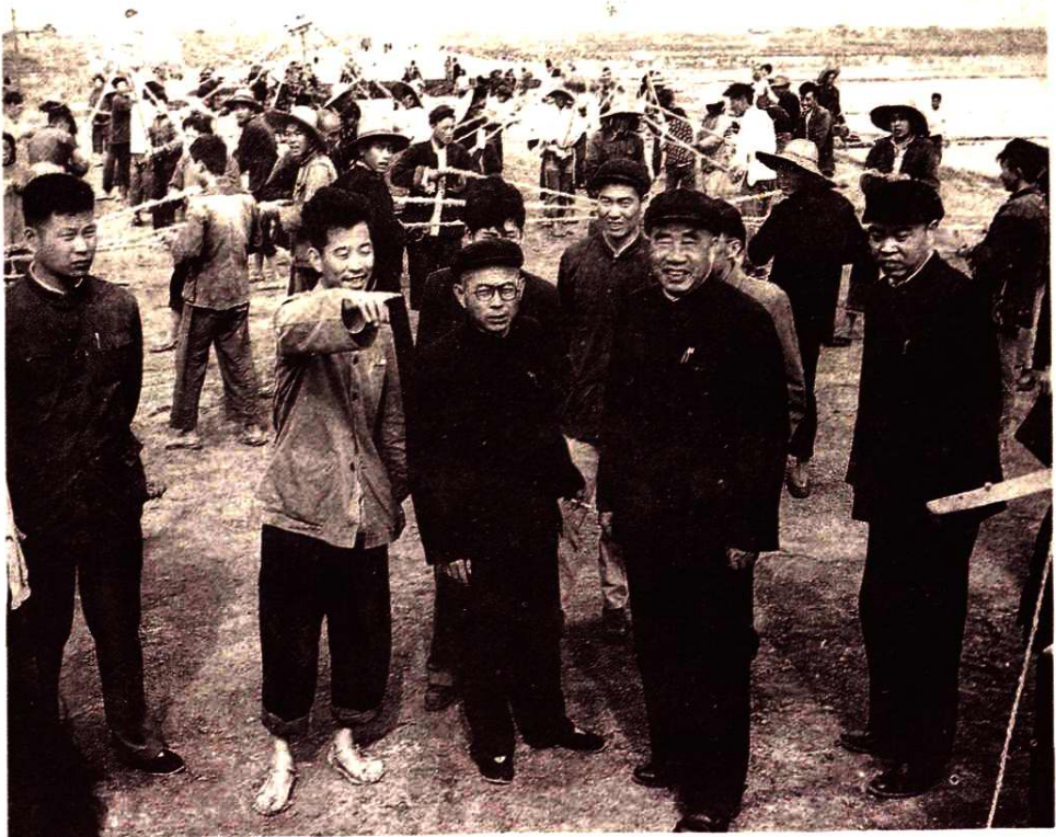
朱德 1958 年 4 月在肥西张公圩工地视察
