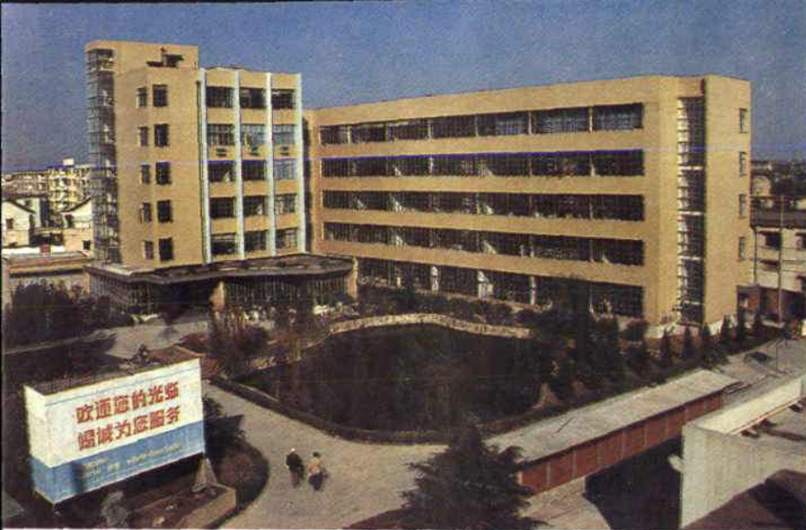
海盐电力仪表厂 仪表大楼
