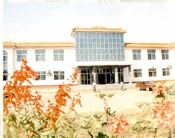
县自来水公司办公楼
